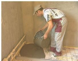
Заливка стяжки плавающего пола
