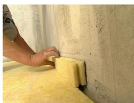
Установка вертикальных разделяющих элементов плавающего пола
